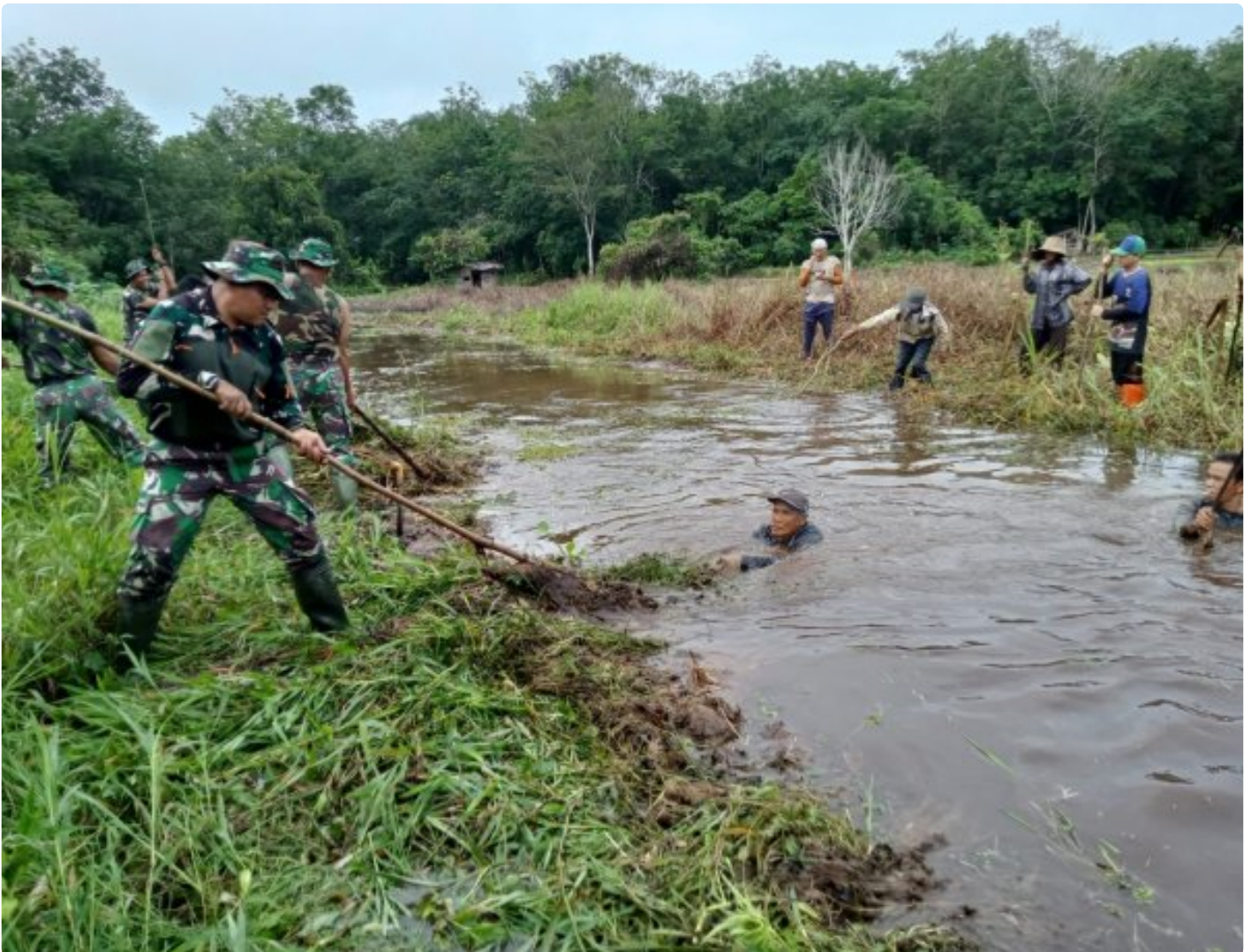
Cegah Batingsor Koramil 1001-05/Lampihong Bersihkan Saluran Air
