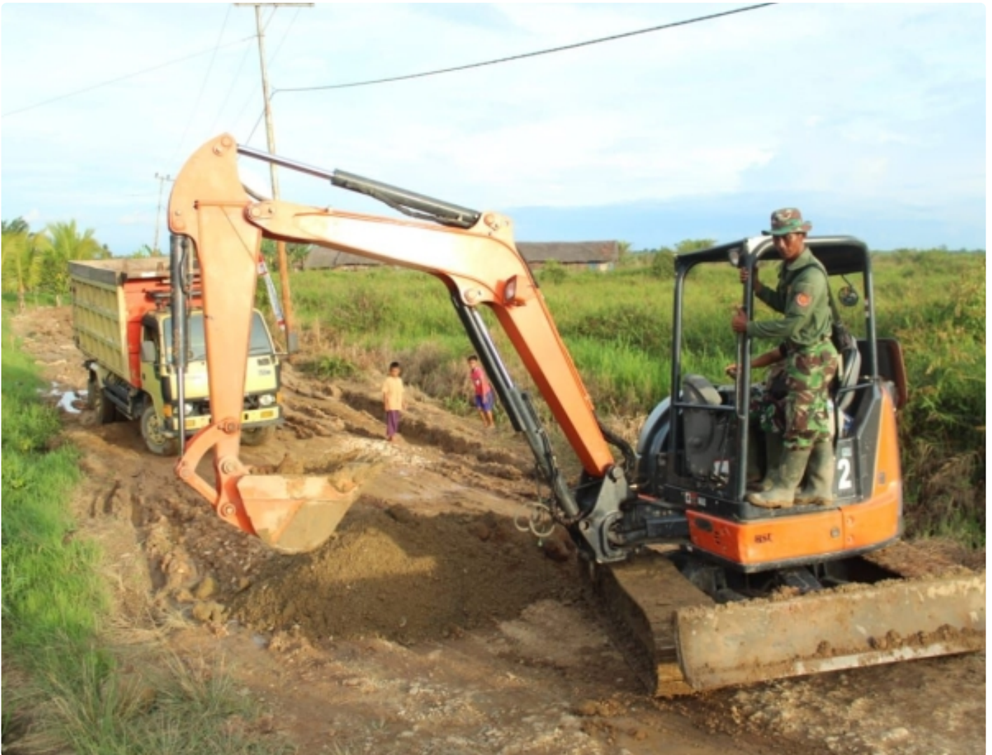
Satgas TMMD ke-115 Kodim 1001/Hsu-Blg Kerahkan Excavator
