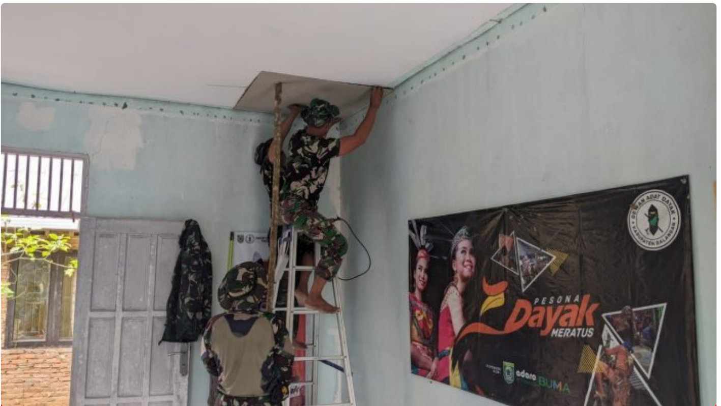
Kodim 1001/HSU-Balangan Rehap Kantor DAD Kabupaten Balangan
