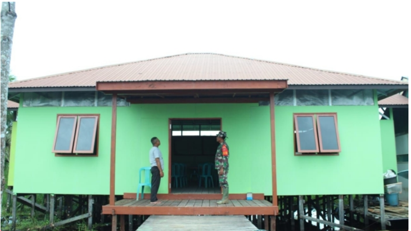
Rehab Balai BPD Rampung 100 Persen
