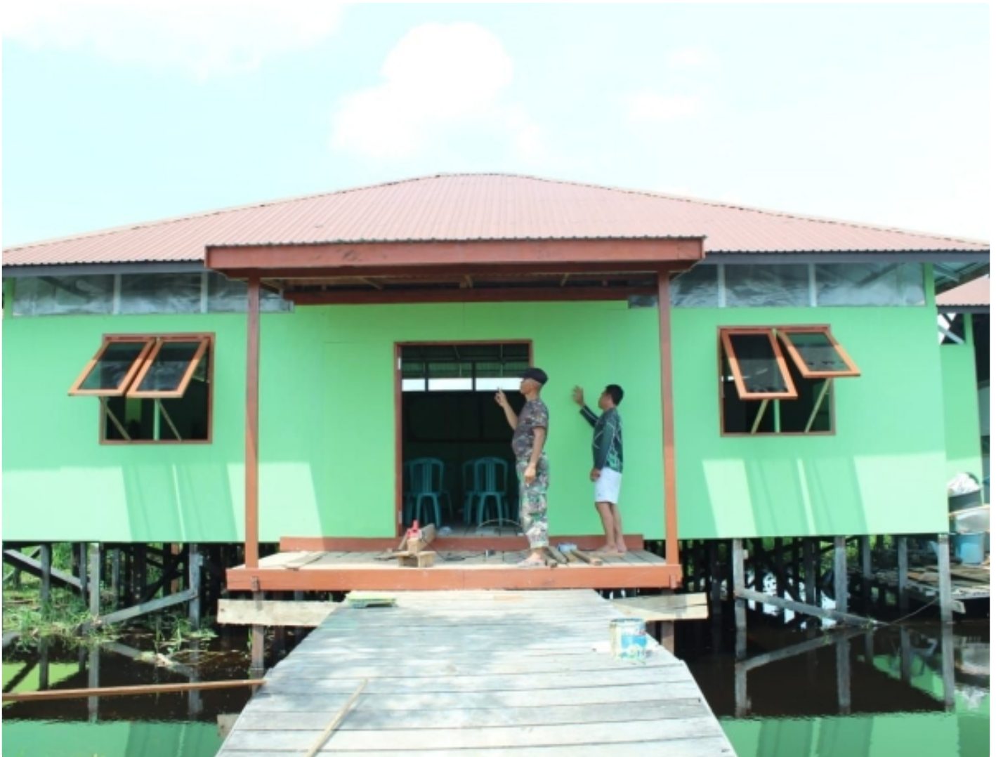
Sasaran Fisik TMMD Ke-115 Rehab Balai BPD Capai Tahap Finising
